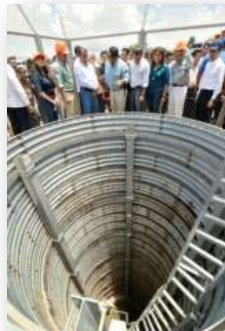
ペリネチエ地区の集水井（竣工式で）
