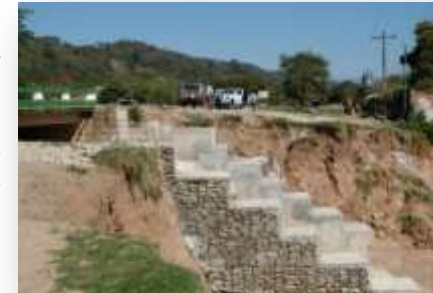
ボリビア国道7号線の路肩補強
