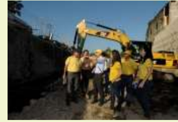
ハリケーン被害を受けた現場の水路拡幅・護岸工事を視察するDACGERの技術者と日本人専門家
